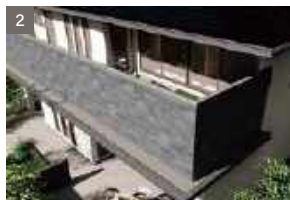
青空へと張り出したアウトドアリビング ハイウォールバルコニー
