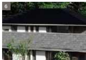
街の景観にも美しく映える 瓦一体型太陽光発電 (15.76kW)
